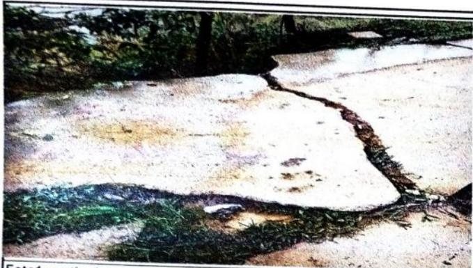
Foto 1: patio del establecimiento donde se puede evidenciar la necesidad de sustitucion de plancha de concreto
